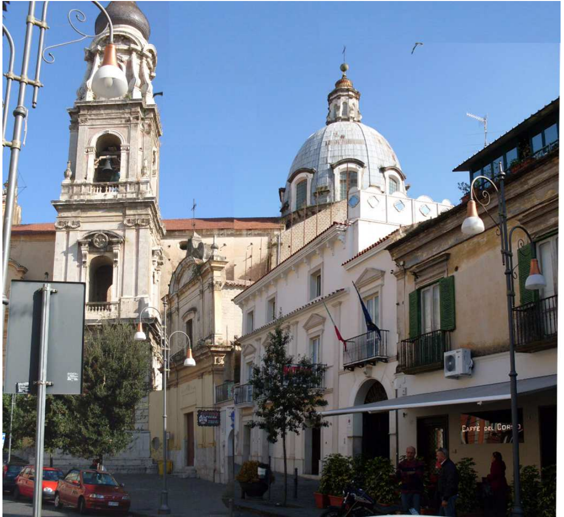
Figura n.3 – Basilica del Corpus Domini
