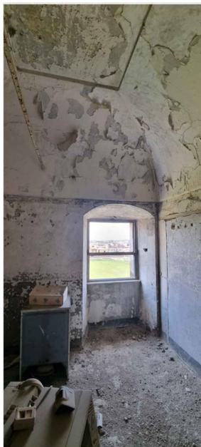
TIPO DI VOLTA: volta a schifo
