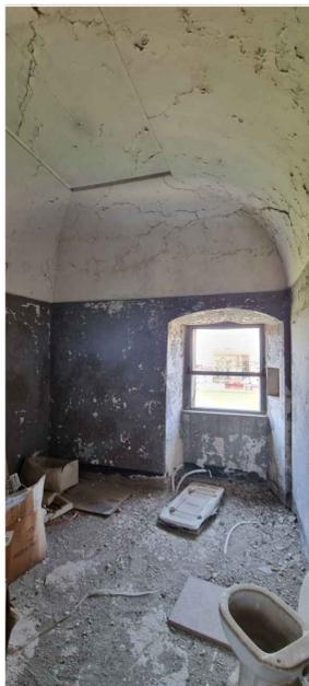
TIPO DI VOLTA: volta a schifo
