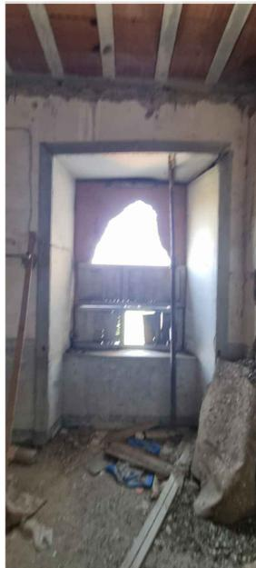
TIPO DI VOLTA: solaio piano laterocementizio
