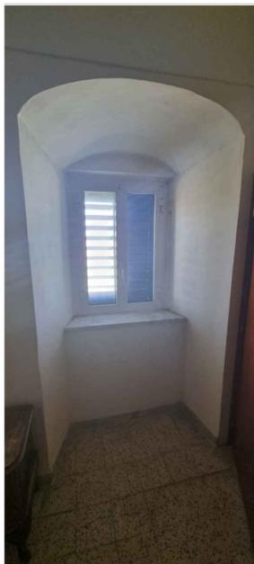
TIPO DI VOLTA: volta a schifo
