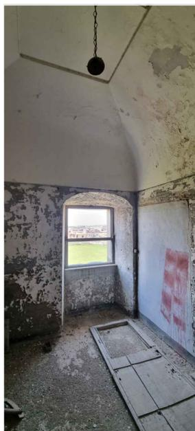
TIPO DI VOLTA: volta a schifo
