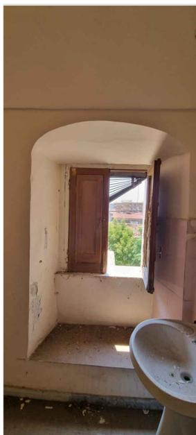
TIPO DI VOLTA: volta a schifo
