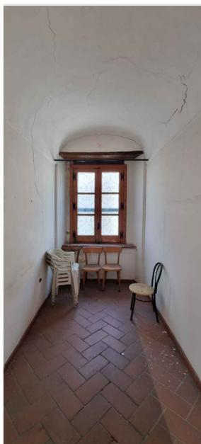
TIPO DI VOLTA: volta a botte
