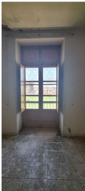
TIPO DI VOLTA: solaio piano
