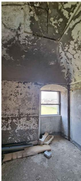
TIPO DI VOLTA: volta a schifo
