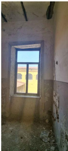
TIPO DI VOLTA: solaio piano con putrelle
