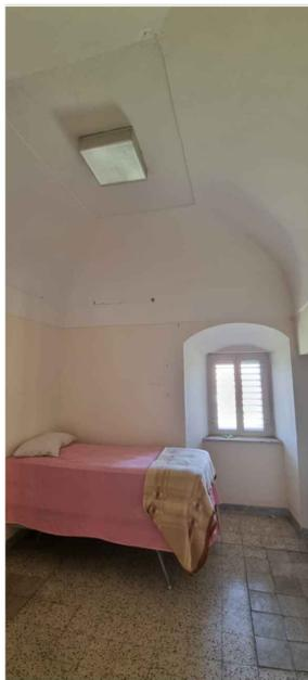
TIPO DI VOLTA: volta a schifo
