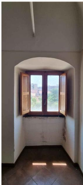
TIPO DI VOLTA: volta a schifo e volta a botte
