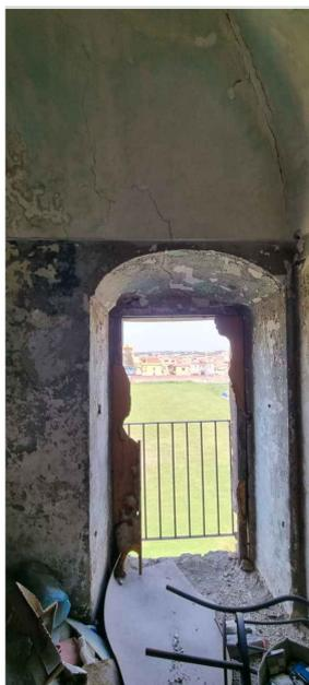
TIPO DI VOLTA: volta a schifo
