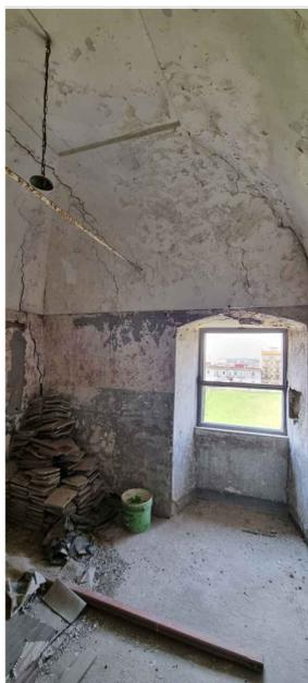
TIPO DI VOLTA: volta a schifo
