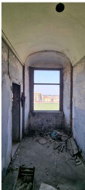
TIPO DI VOLTA: volta a botte
