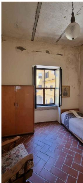
TIPO DI VOLTA: solaio piano con putrelle
