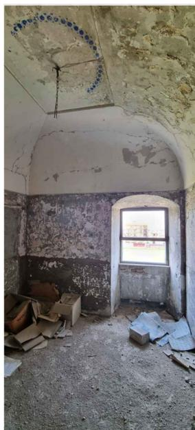
TIPO DI VOLTA: volta a schifo
