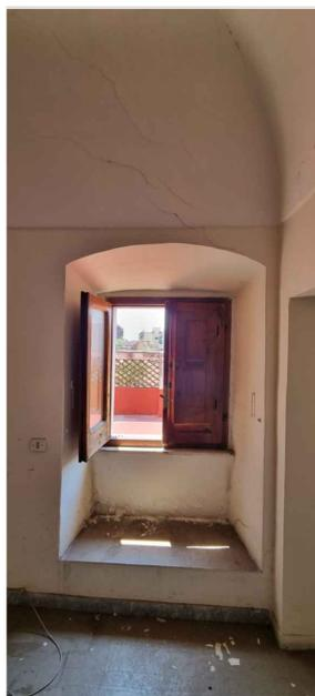
TIPO DI VOLTA: volta a schifo
