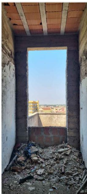
TIPO DI VOLTA: solaio piano laterocementizio
