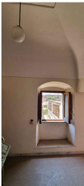
TIPO DI VOLTA: volta a schifo
