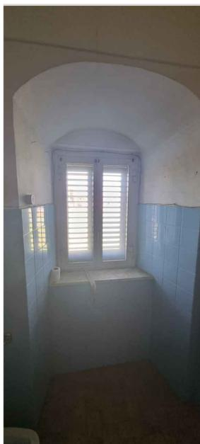
TIPO DI VOLTA: volta a schifo
