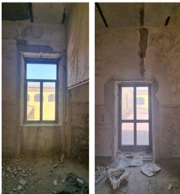
TIPO DI VOLTA: solaio piano con putrelle
