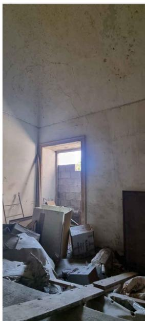
TIPO DI VOLTA: volta a schifo
