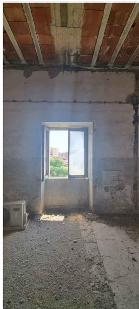
TIPO DI VOLTA: solaio piano laterocementizio
