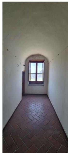
TIPO DI VOLTA: volta a botte
