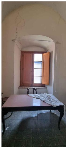
TIPO DI VOLTA: volta a schifo lunettata
