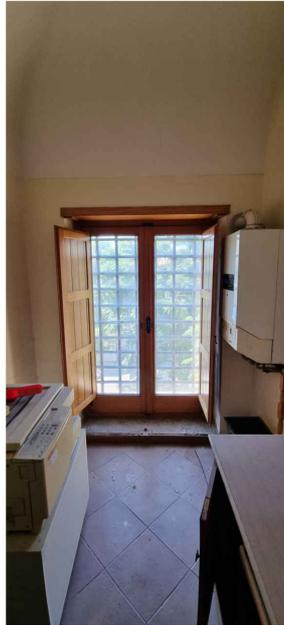
TIPO DI VOLTA: volta a schifo
