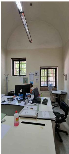
TIPO DI VOLTA: volta a botte
