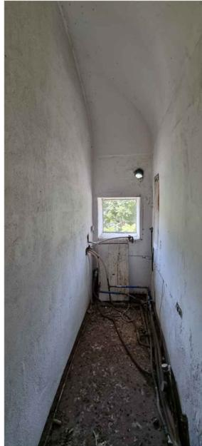
TIPO DI VOLTA: volta a schifo
