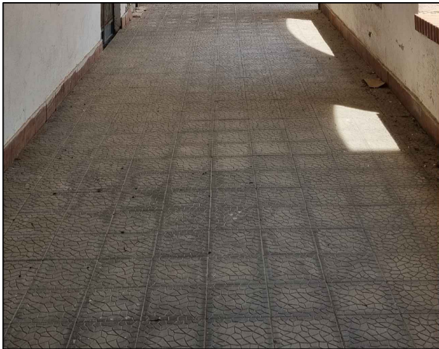
Pavimentazione per esterni in piastrelle di calcestruzzo stampato, formato 20x20 cm.
