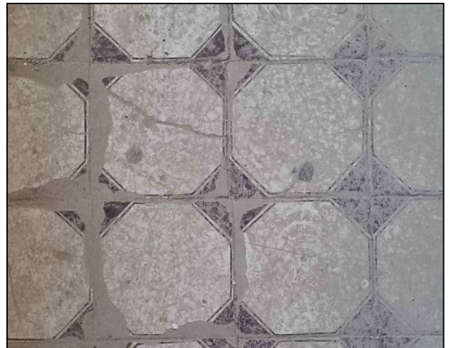
Pavimento in piastrelle di ceramica smaltata con disegno, formato 20x20 cm.
