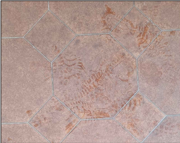
Pavimento in piastrelle ottagonali con tozzetto quadrato, entrambi in ceramica smaltata.
