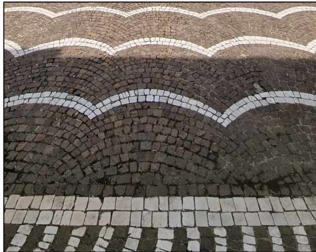
Pavimentazione in basoli di marmo e basalto, formato 10x10 cm, con posa a pavè.
