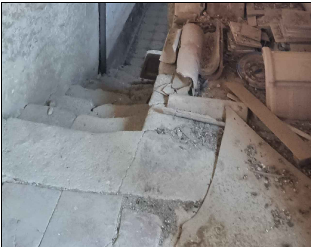
Pavimento in elementi sbozzati di pietra naturale, formati vari.
